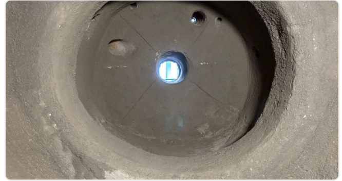
Dehnfuge mit Fasermatten fachgerecht gestopft
