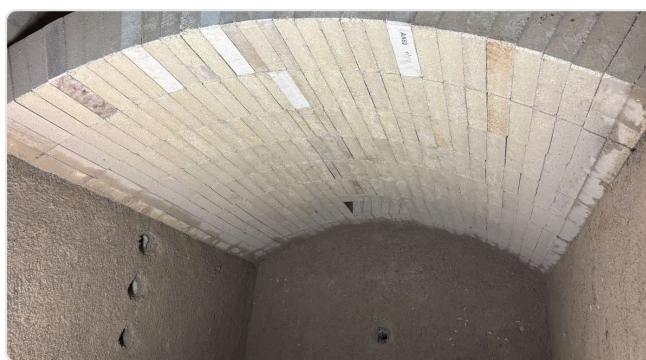
Nová klenba ve spalovací komoře
