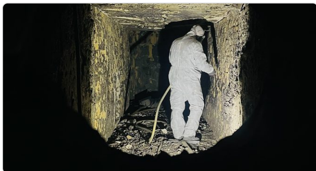
Pohled průlezem: jeden vstup pro člověka, materiál i ústupovou cestu
