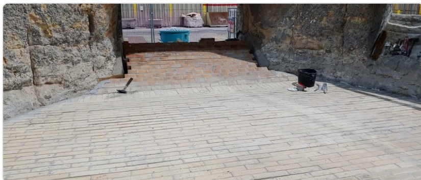
Čerstvě vyzdřená část pece před řízeným náběhem
