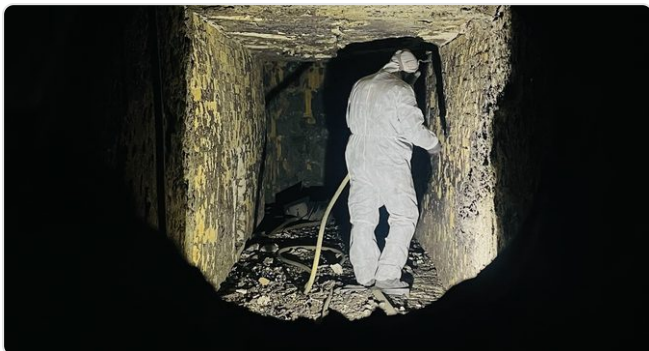
Blick durch das Mannloch: ein Eingang für Mensch, Material und Rückweg
