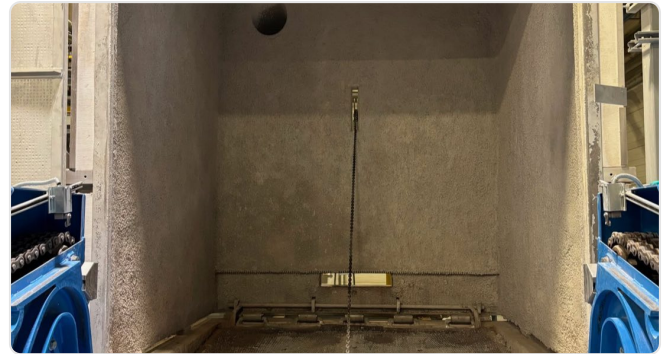
Fertig zugestellte Haube vor der Rückmontage
