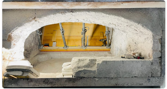
Gereinigte Ofenöffnung vor dem Neuaufbau
