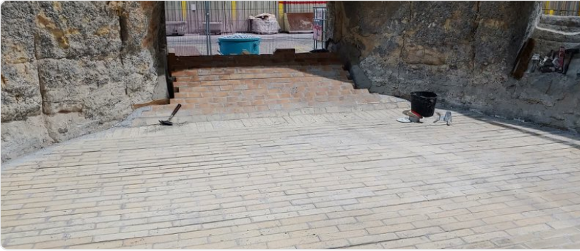
Frisch zugestellter Ofenbereich vor dem kontrollierten Aufheizen
