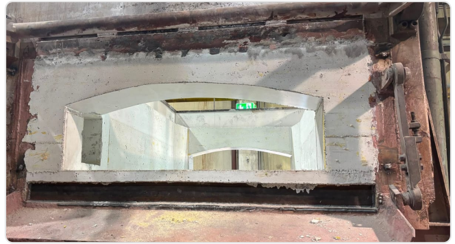
Ofenfront: Öffnung und Tür passen zur neuen Geometrie
