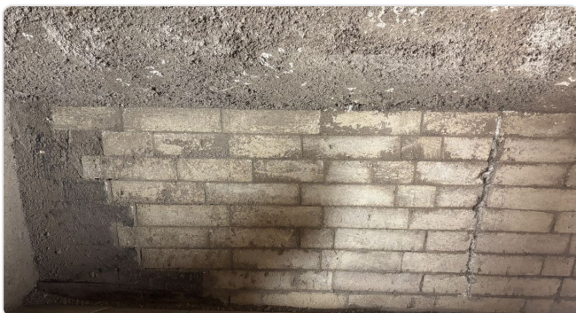
Treppenförmig verzahnter Übergang, rechts die Dehnfuge
