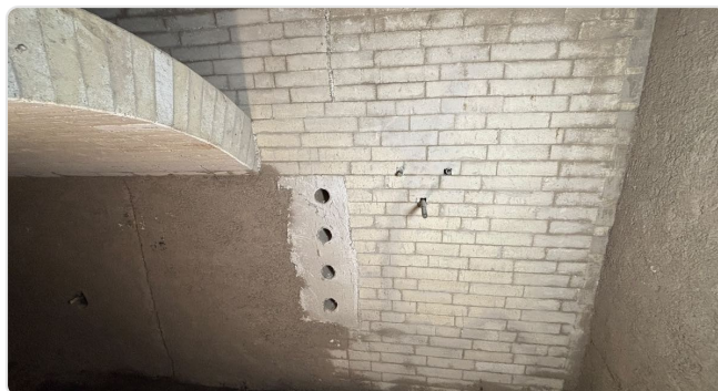
Beim Einbau gesetzte Sekundärluftöffnungen
